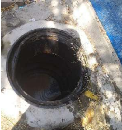
Kanalizasyon Sistemine Verilecek Atıksuların Ön Arıtımı için Kapalı Yağ Tutucu (Tınaztepe Yerleşkesi)
