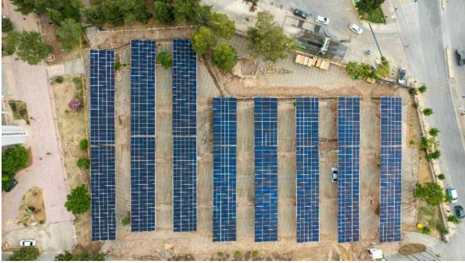
DEÜ Uygulama ve Araştırma Hastanesi'nde Güneş Enerji Panelleri
