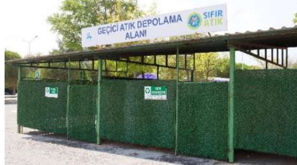
Geçici Atık Depolama Alanları
