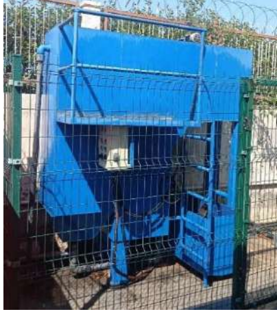
Kanalizasyon Sistemine Verilecek Atıksuların Ön Arıtımı için Kapalı Yağ Tutucu (15 Temmuz Sağlık ve Sanat Yerleşkesi)
