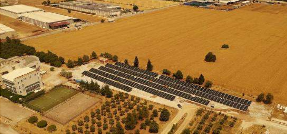
Torbali Kampüsünde Güneş Enerji Panelleri
