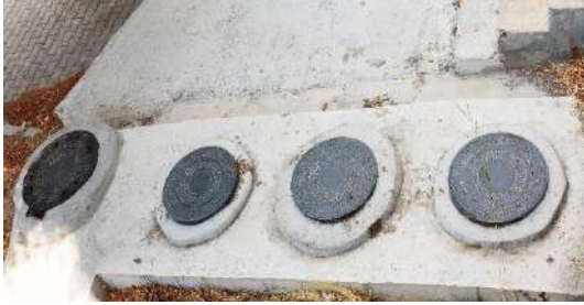
Kanalizasyon Sistemine Verilecek Atıksuların Ön Arıtımı için Kapalı Yağ Tutucu (15 Temmuz Sağlık ve Sanat Yerleşkesi)
