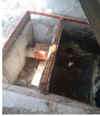
Kanalizasyon Sistemine Verilecek Atıksuların Ön Arıtımı için Kapalı Yağ Tutucu (15 Temmuz Sağlık ve Sanat Yerleşkesi)
