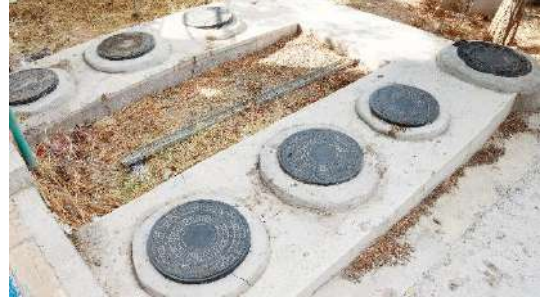
Kanalizasyon Sistemine Verilecek Atıksuların Ön Arıtımı için Kapalı Yağ Tutucu (15 Temmuz Sağlık ve Sanat Yerleşkesi)
