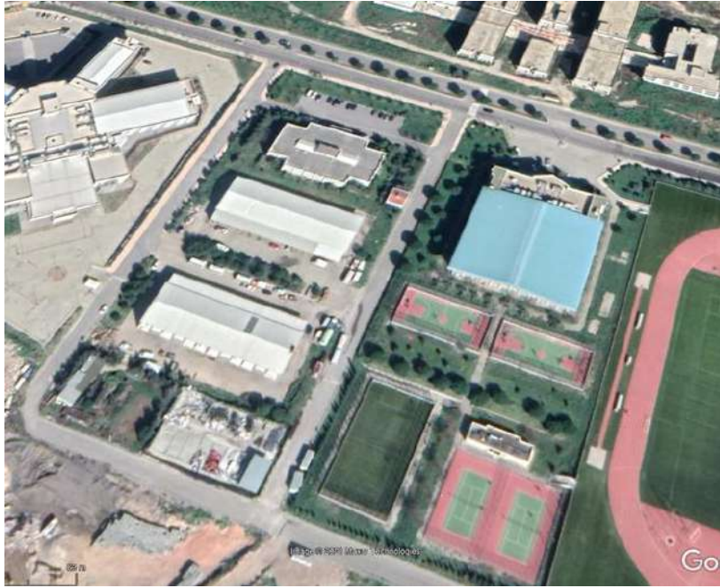
Tınaztepe Yerleşkesi Teknik Atölyeler Binası ve Çevresindeki Ağaçlar
