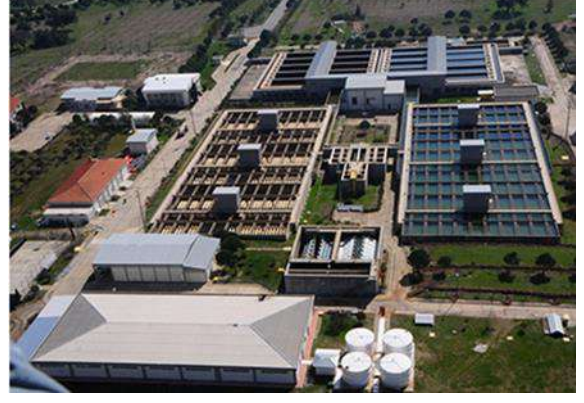
Arıtma Tesisinin Genel Görünümü
