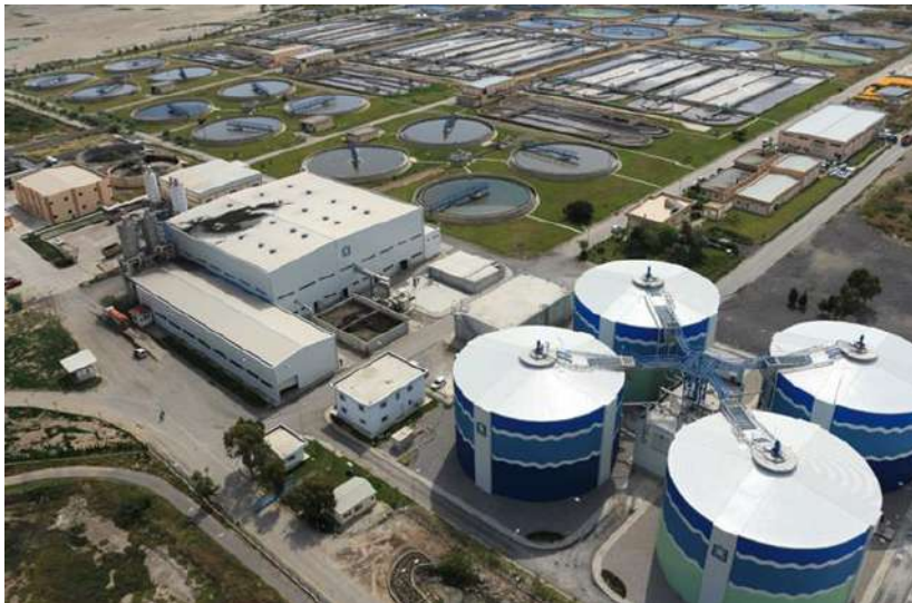
İzmir Büyükşehir Belediyesi Merkezi Atıksu Arıtma Tesisi
