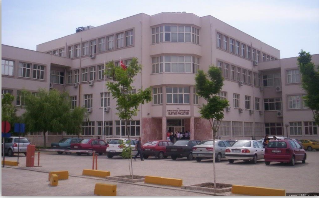
FOTOĞRAF 2: İşletme Fakültesi Binası
