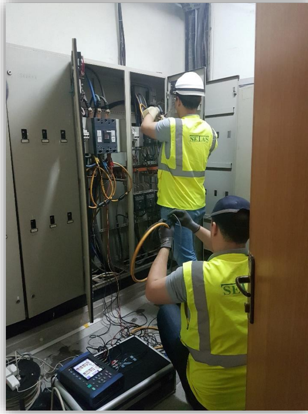
FOTOĞRAF 34: Enerji Analizörü Bağlantısı
