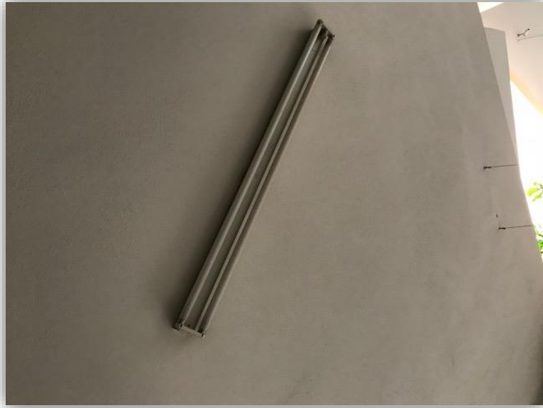
FOTOĞRAF 40: Mevcut Aydınlatma Armatür Görüntüsü
