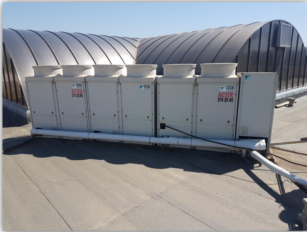
FOTOĞRAF 25: VRF Sistem Görüntüsü
