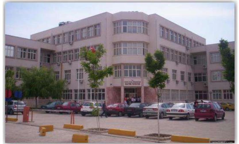
FOTOĞRAF 2: İşletme Fakültesi Binası
